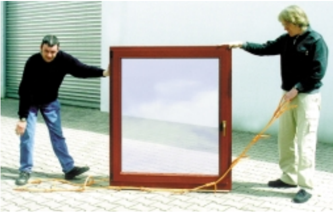
Bild 5: So wird's gemacht: Fenster auf das Tragenetz stellen...
