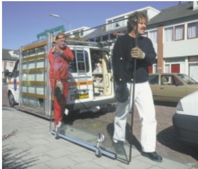
Bild 3: Scheiben bis zu 200 kg können mit Hilfe des Schlittens mühelos transportiert werden. Er besteht aus einer Schiene auf vier kleinen Rädern sowie zwei Saugern
