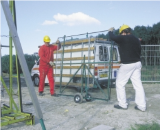
Bild 2: Die Weiterentwicklung des gängigen Transportwagens wurde mit einem Satz Verlängerungsstangen für große Glasscheiben sowie Haltevorrichtungen ausgestattet
