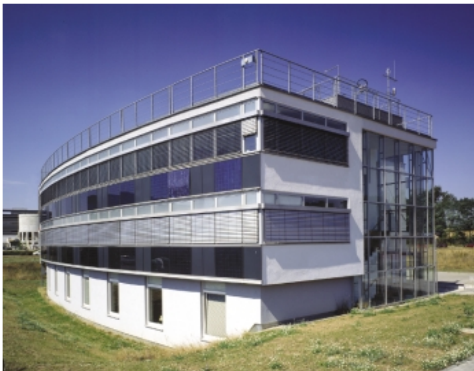
Bild 1: Modulares Fassadensystem an der Südseite des Solarzentrum in Frankfurt/Oder
