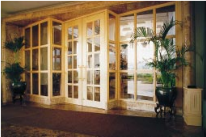
Meranti-Hölzer erfüllen die in Europa gestellten hohen Anforderungen an Holz für Rahmenkonstruktionen
