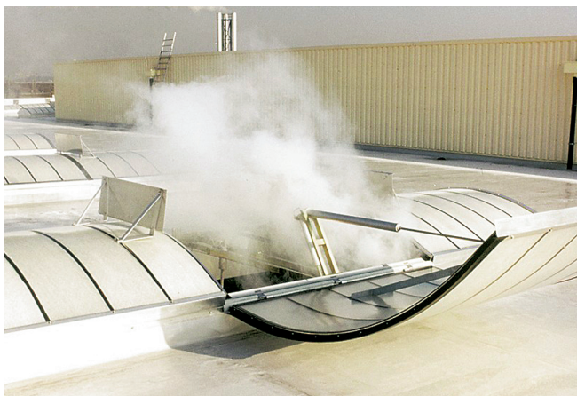
Wirtschaftliche und effektive Lösung zur Entrauchung: Lichtkuppeln oder Lichtbänder mit integrierten RWA
