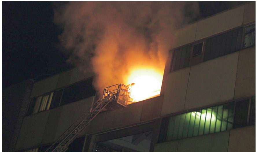
Starke Rauch- und Hitzeentwicklung aufgrund fehlender Rauch- und Wärmeabzugsanlagen verhinderten einen direkten Innenangriff auf den Brandherd
