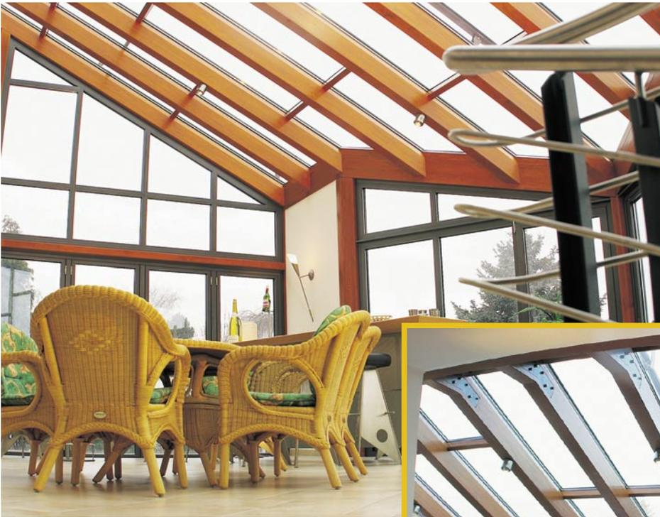
Viel Licht für die Galerie: Die eingesetzten Sparren ermöglichten eine beträchtliche Dachspanne ohne zusätzliche Stahlverstärkung
