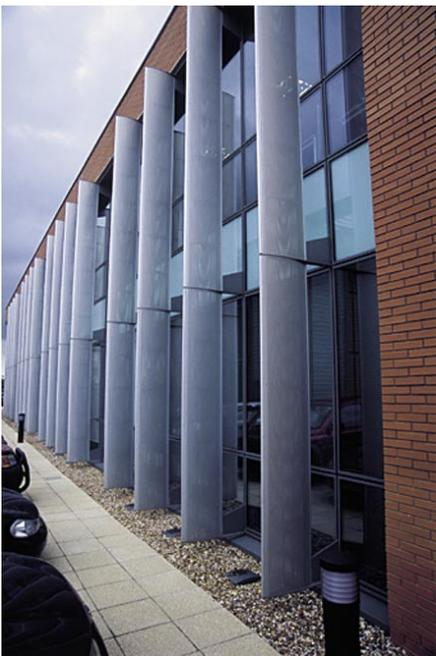
Die Anordnung der einzelnen Lamellen variiert von fester bis zu manuell oder elektronisch gesteuerter, beweglicher Installation
