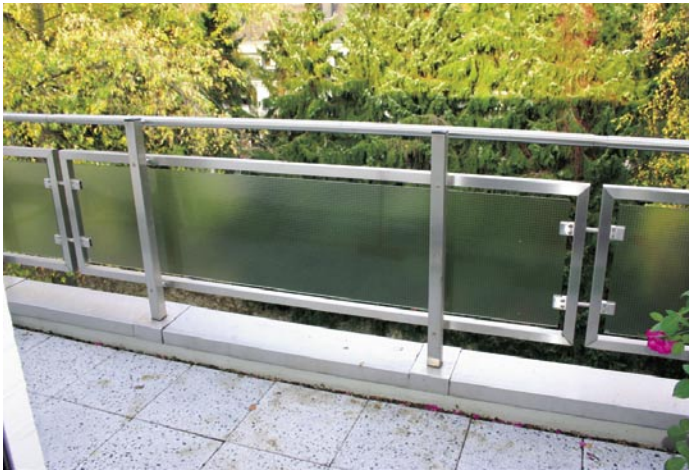
Bild 2: Ansicht der mittleren Glasscheibe in der Frontseite
